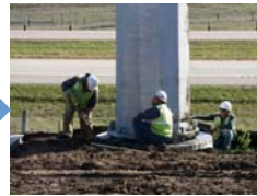
Replace and Regrade Fill
